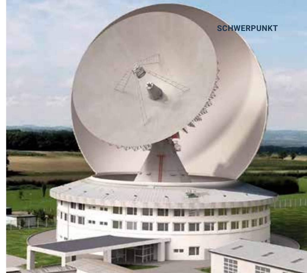
Die Hauptkomponenten von TIRA sind ein beweglicher Parabolspiegel mit 34 Meter Durchmesser, ein L-Band-Radar und ein Ku-Band-Radar. Das L-Band-Radar dient dabei dem Tracking (Verfolgen) von Weltraumobjekten und das Ku-Band-Radar für deren Abbildung
