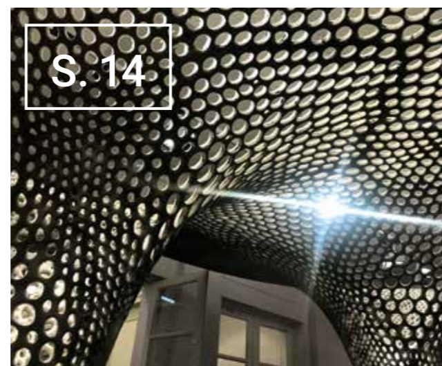
Ungewöhnliche Oberflächen durch Gradientenbeton
