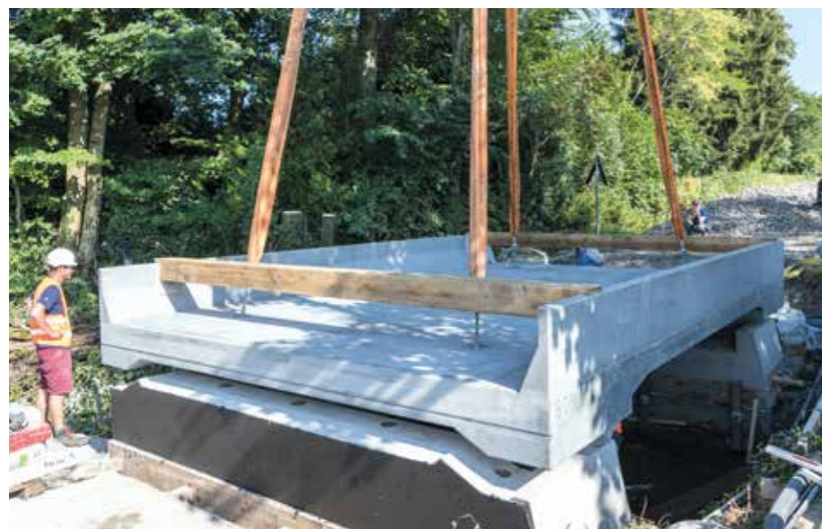
Einheben des Fertigteils der Eisenbahnbrücke
