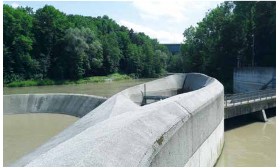
Eigenwillige Formgebung des Betons beim Wasserkraftwerk Keselstraße
