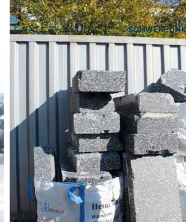
Abrissabfälle aus Wärmedämmverbundsystemen
