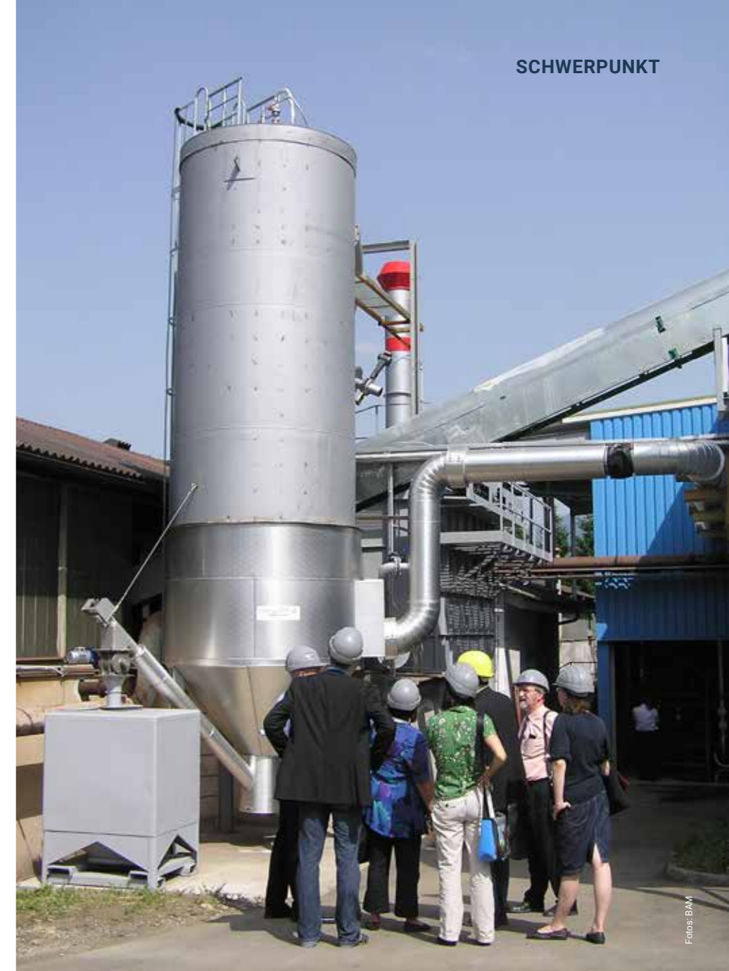
Die AshDec-Pilotanlage in Leoben, Österreich, mit einem Durchsatz von ca. 200 kg/h
