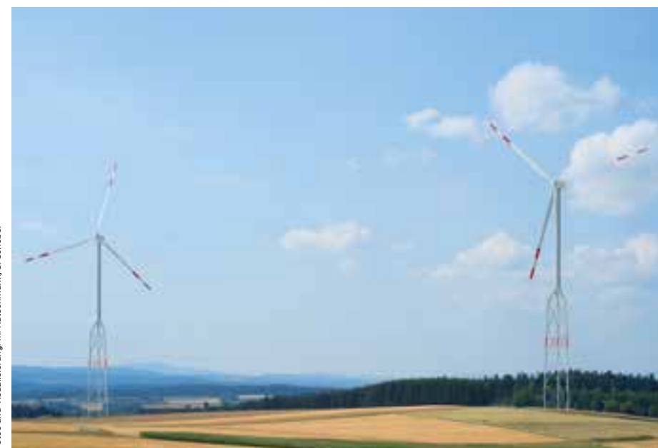
Neuartiger Stahlhybridturm mit drei Traggliedern und Übergangsstück von Y. Petryna, TU Berlin, FG Statik und Dynamik; Notus Energy Construction, G. Grawe; Ostseestahl, T. Kühmstedt
