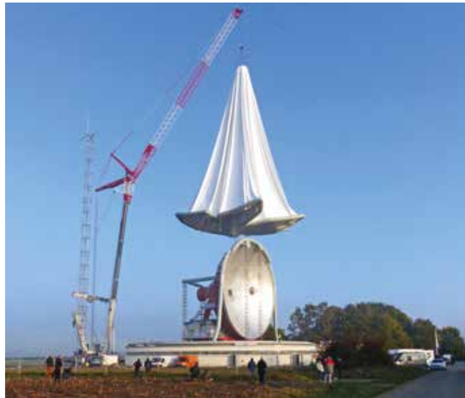
Einhub der neuen Membrane über die Antenne 1
