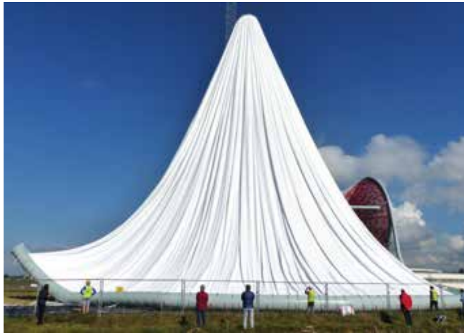
Anhebeversuch der Membrane mit dem Stabilisierungsschlauch
