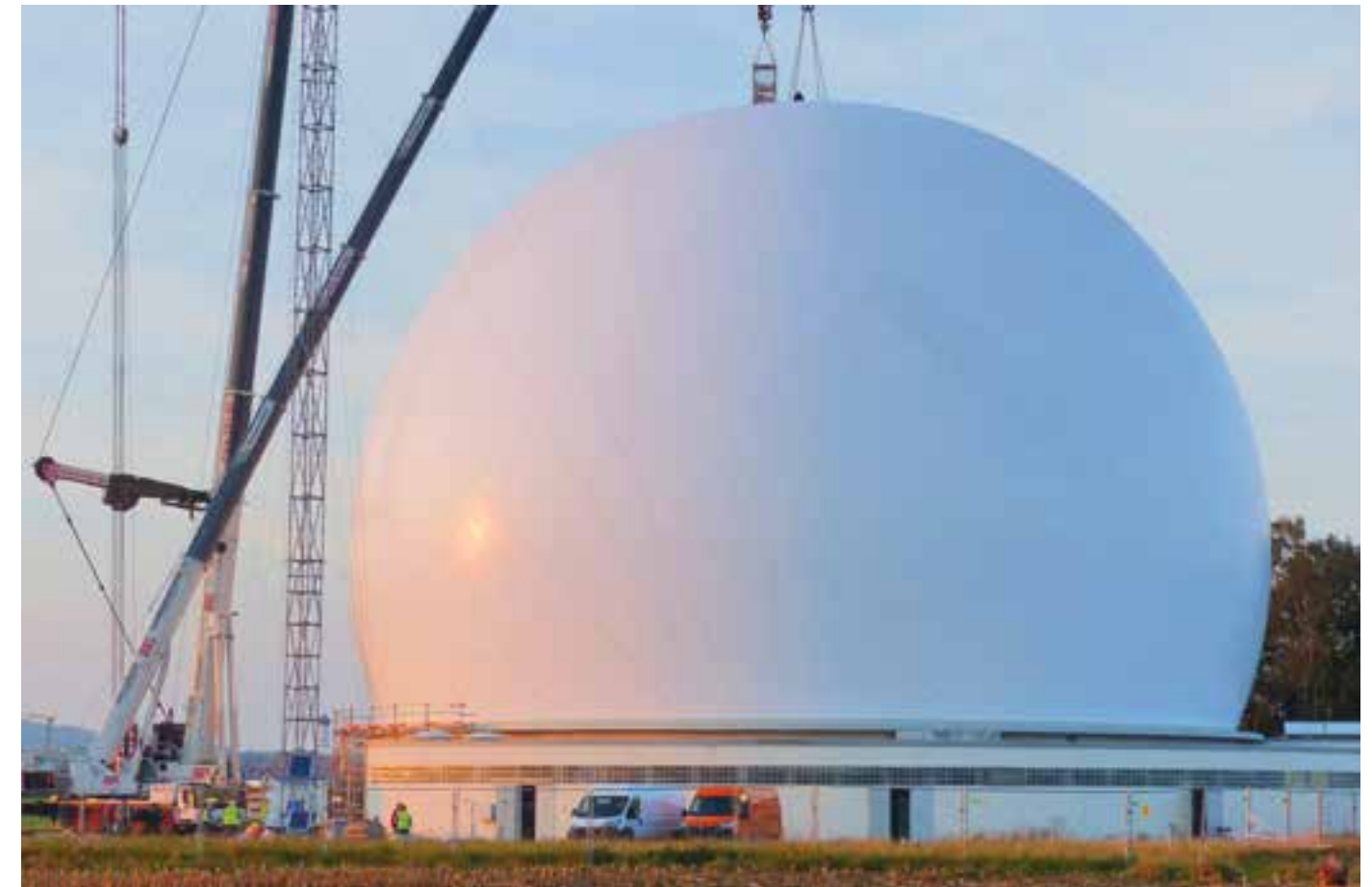
Das dritte Radom über Deutschlands erster Großantenne
