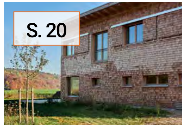
Holzbau in der Praxis
