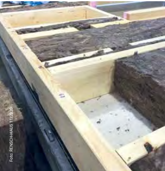
Außenwand in der Entstehung
